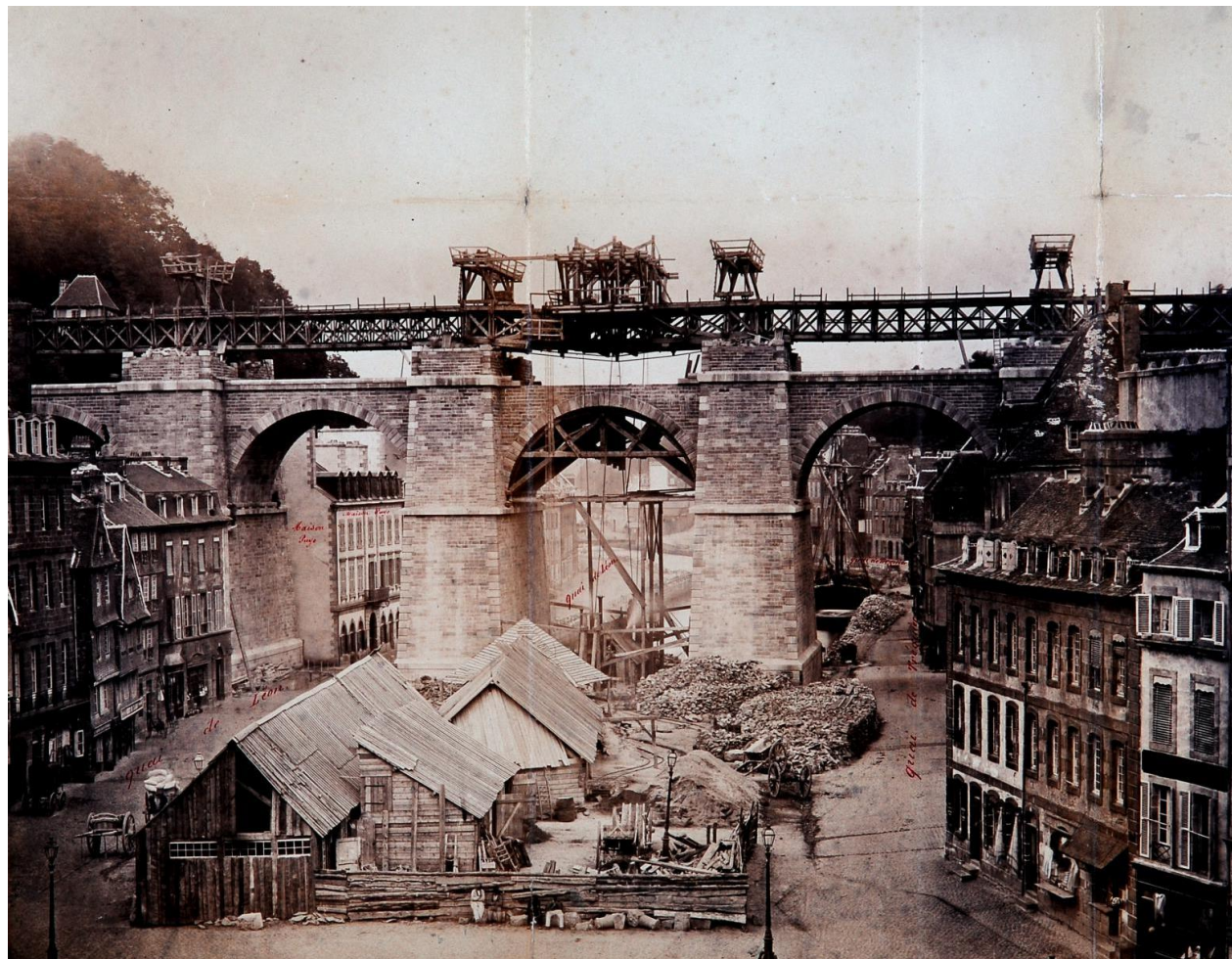
Figure 30. La construction du viaduc, entre 1861 et 1863 (Morlaix)
